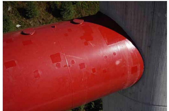
Inspektion einer Talbrücke (hier: Querriegel eines Brückenpfeilers)
