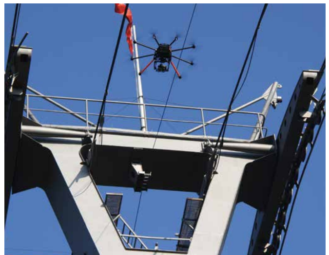
Inspektion eines Seilbahnpylons
